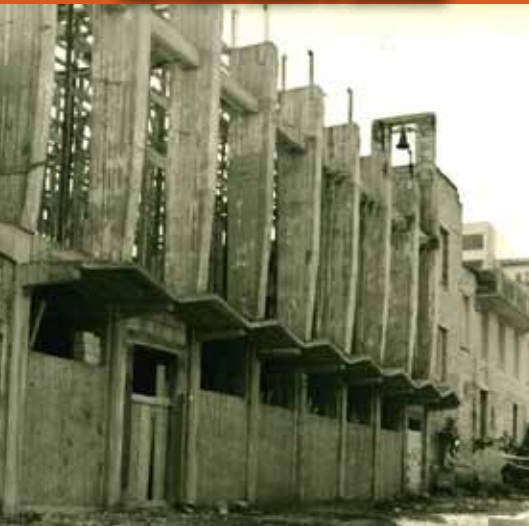
1960 Il nuovo oratorio in costruzione
